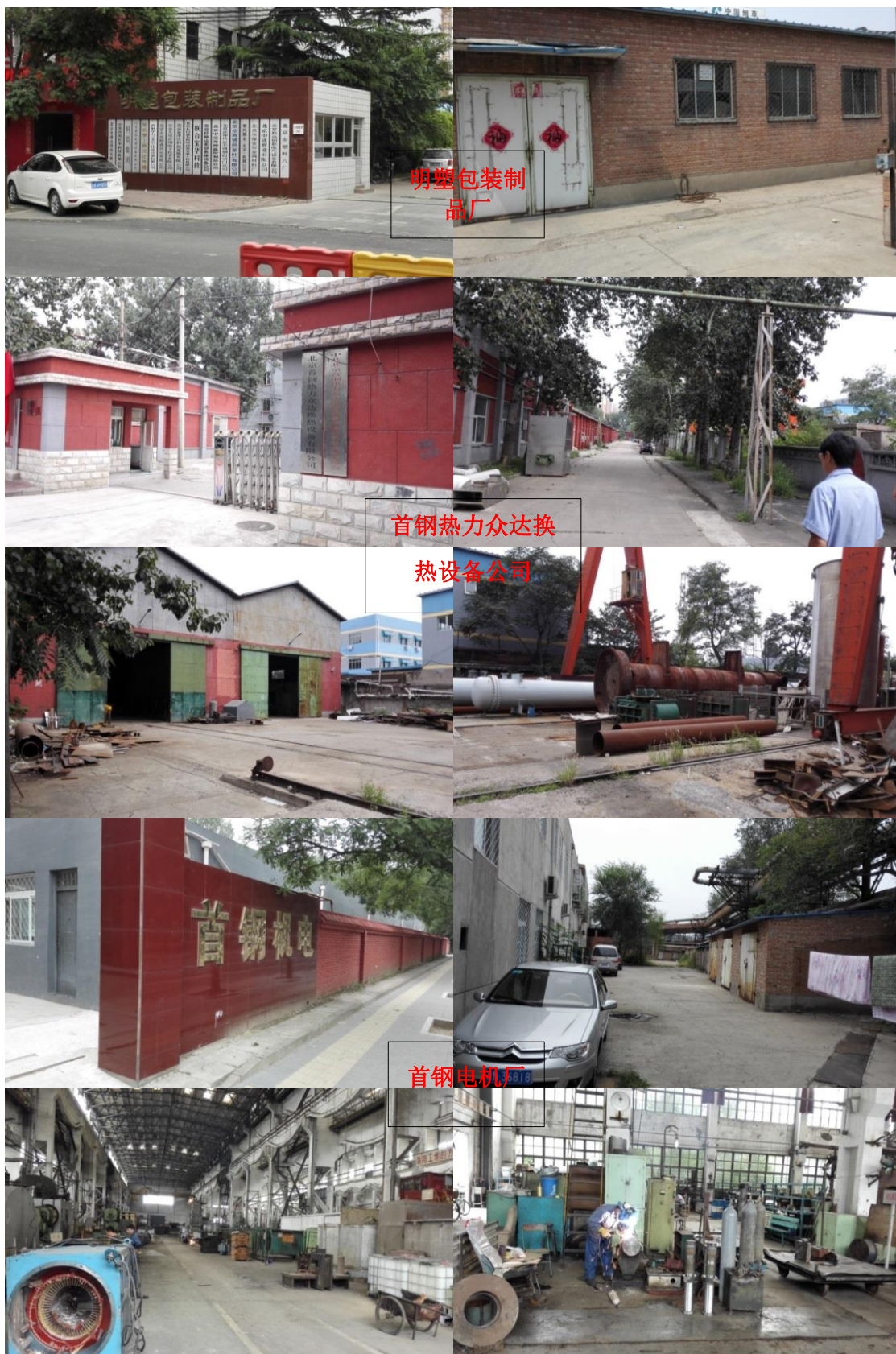
图 1.3-12 调查区域内部分厂房现存状况
