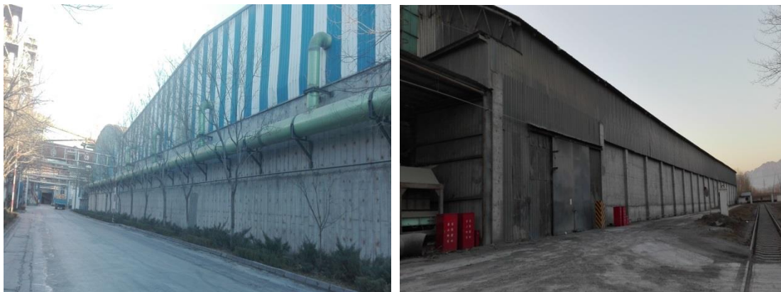
图 2.1-4 全封闭式负压大棚
