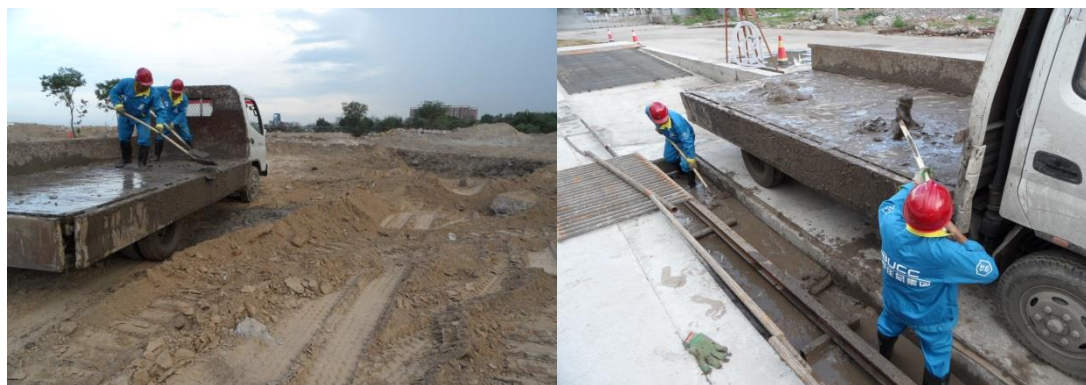
施工人员正清理洗车池泥浆
