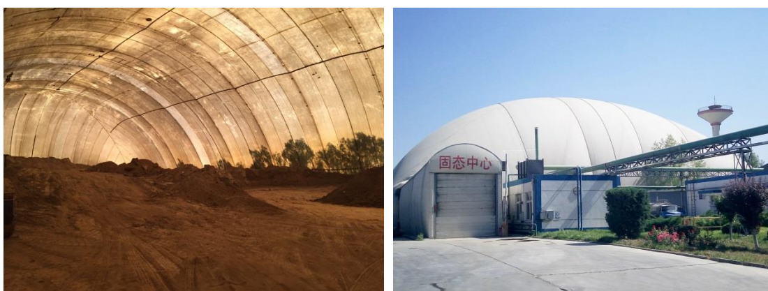
图 2.1-5 全封闭膜结构大棚
