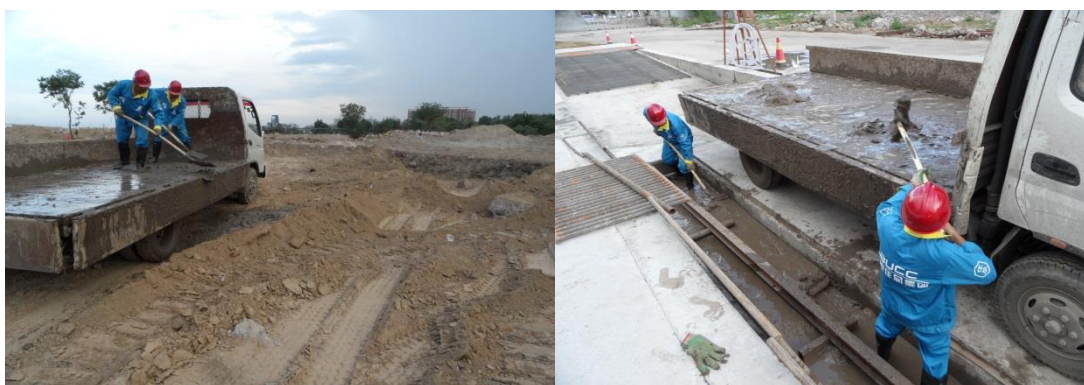
施工人员正清理洗车池泥浆
