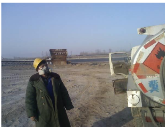
(1) 施工工人防护措施
