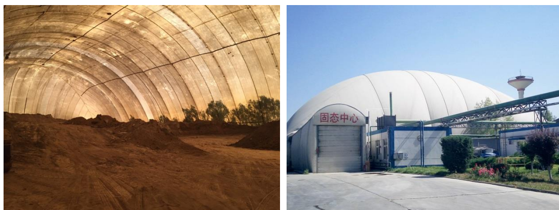
图 5.2-2 北京金隅北水环保科技有限公司膜结构大棚
