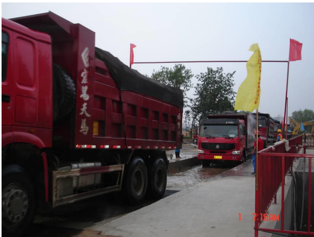
图 3.1-3 红树林公司在其它污染土治理项目中的污染土壤运输洗车照片
